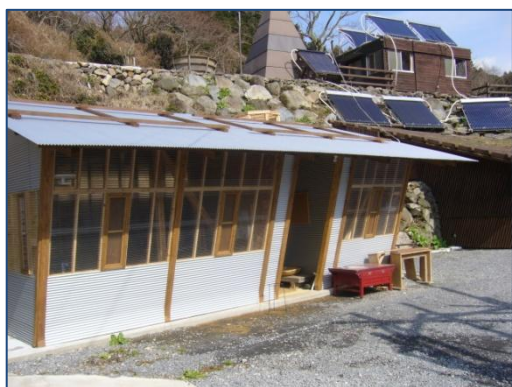
新たに設置された発電棟
