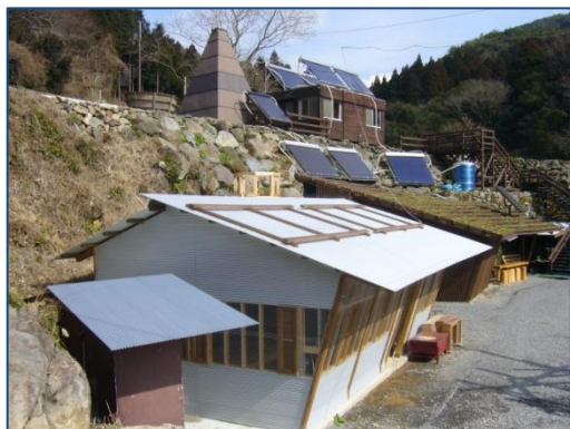
手前が発電棟
