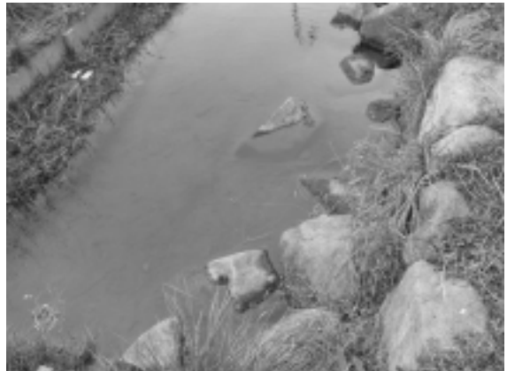
コンクリート U 字溝をワンドのある水路へ
