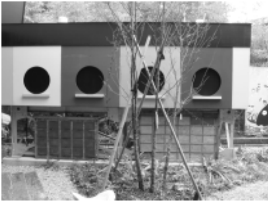
雨水タンクの外槽
